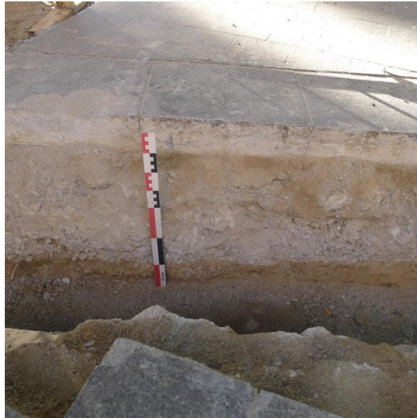
Fig. 6.- Detall del paviment actual del carrer, UE 1, i de les diferents capes preparatòries de formigó, UE 2 i UE 3. Sota aquestes, capa de sauló, UE 4.
