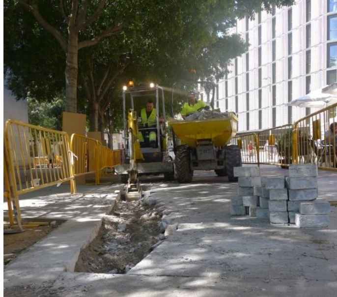
Fig. 2.- Detall del procés d'obertura de la rasa amb mitjans mecànics.
